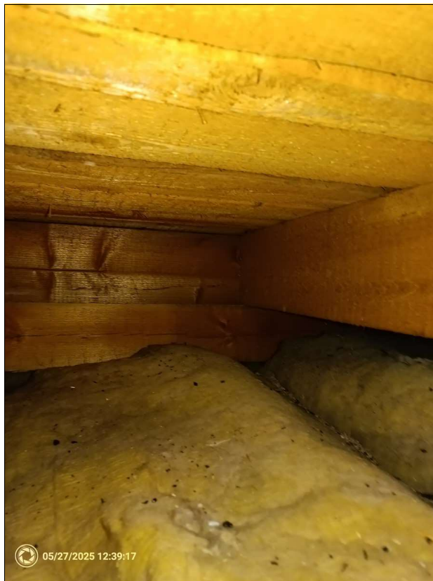
/Foto 3/ Sonda S1 pohled do vzduchové vrstvy pod horním dřevěným pláštěm, stav dřevní hmoty bednění a konstrukce střechy je v místě sondy a jejího okolí dobrý
