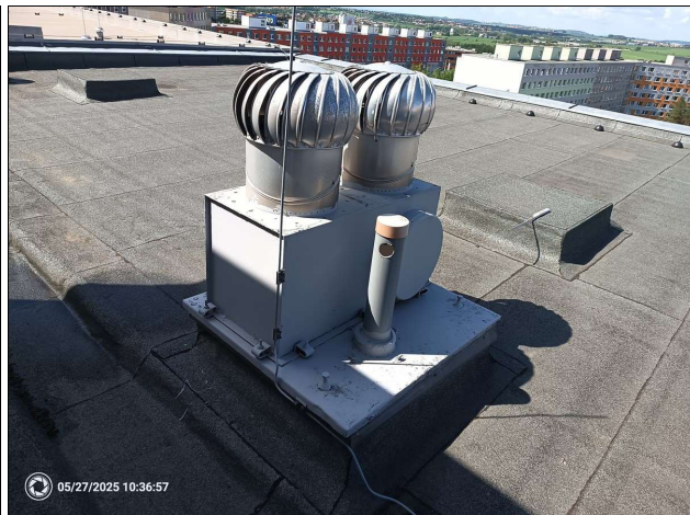
/Foto 8/ Instalační šachta s 2x350mm VZT a 1x 110mm odvětrání kanalizace
