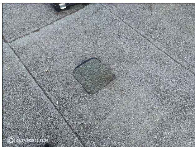
/Foto 4/ Příklad zapravení místa sondy
