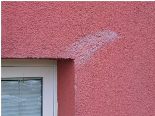
/Foto 12/ Příklad úspěšně opravené diagonální trhliny vycházející z nadpraží okna
