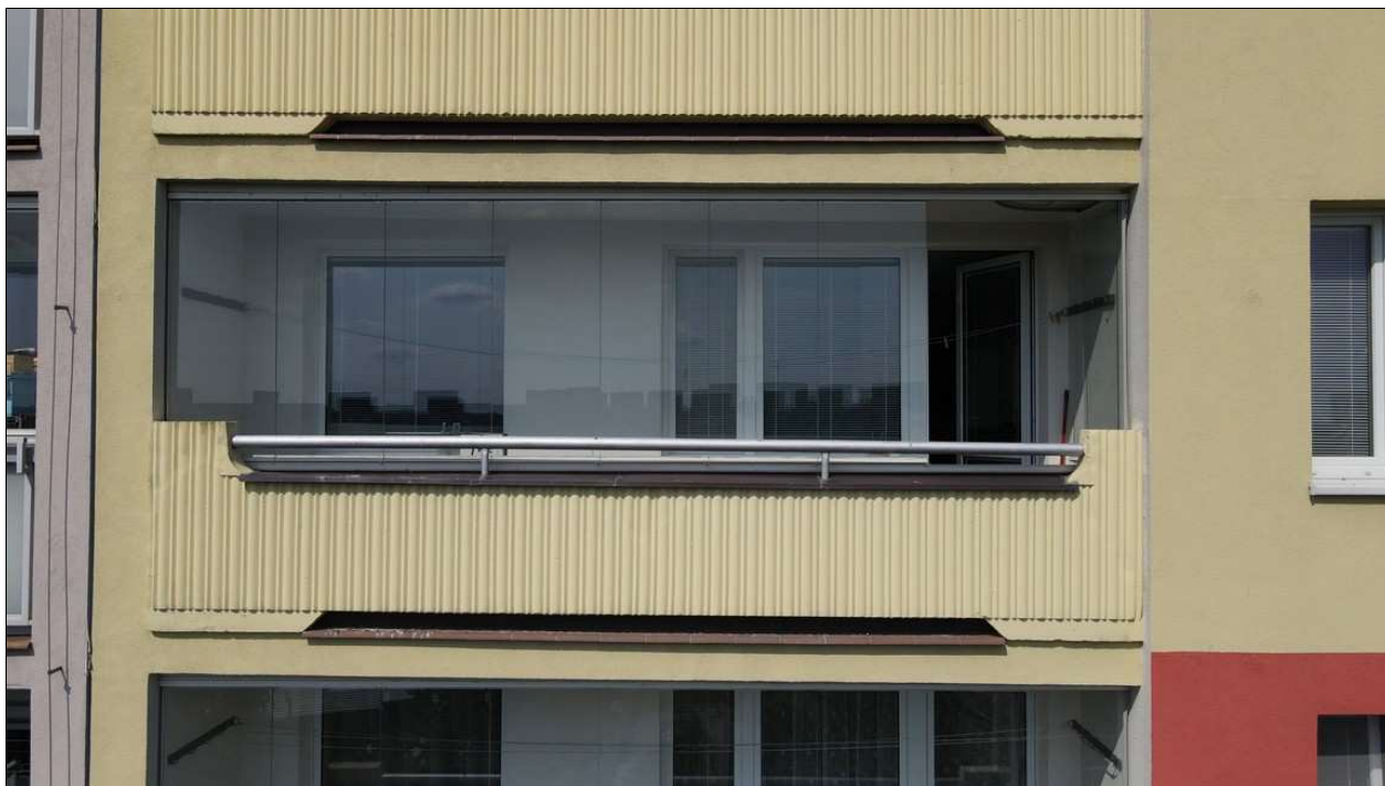
/Foto 17/ Příklad lodžie s betonovým zábradlím
