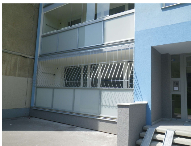
Výplň zábradlí mléčným sklem CONNEX + referenční ukázka jednotného vzhledu mříží (ocel+žárový zinek)
