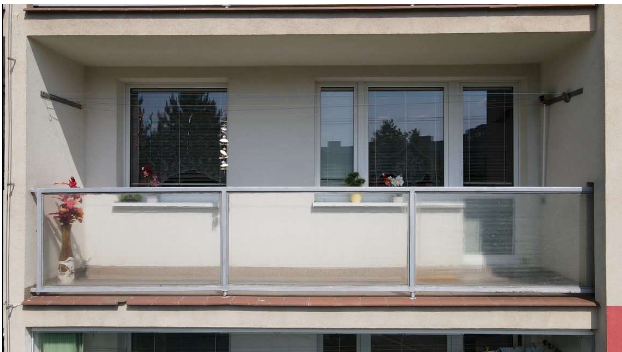
/Foto 16/ Příklad lodžie s ocelovým zábradlím
